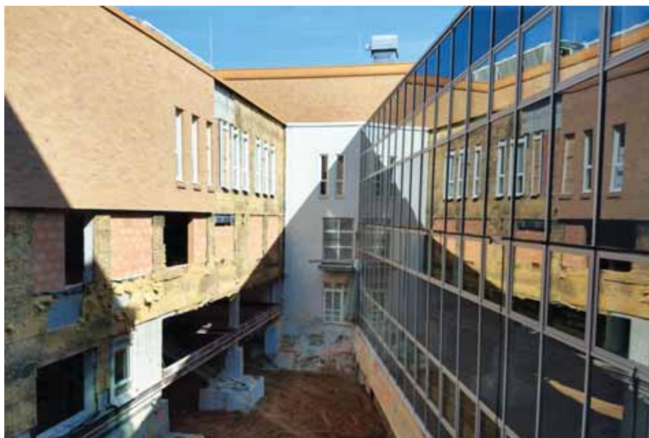
Unübersehbar - die offene Außenwand der Endoskopie.
