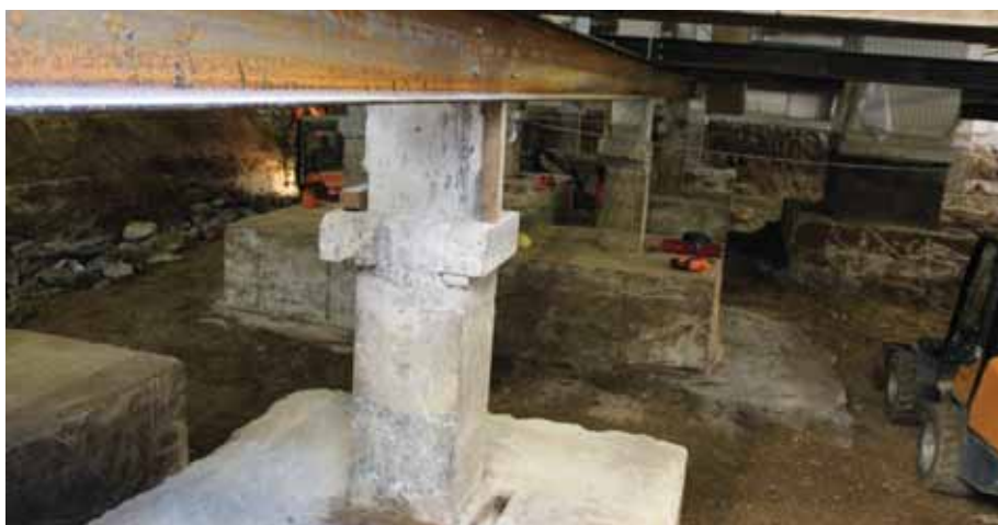
Blick unter die Bodenplatte. Vorbereitungsarbeiten für den weiteren Umbau. Bilder links: Dort wo aktuell noch Baumaterial lagert und Kabel von der Decke hängen, werden künftig Behandlungskabinen und Funktionsräume entstehen.
