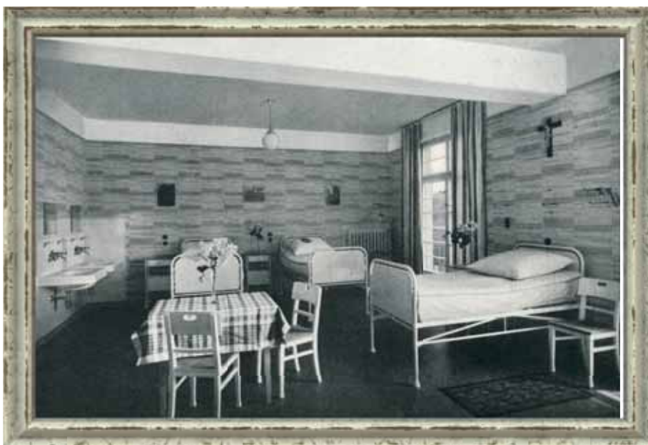
Mehrbett-Zimmer mit Balkonfenster, welches auch im Winter eine kurze, effektive und somit gründliche Durchlüftung ermöglicht.
