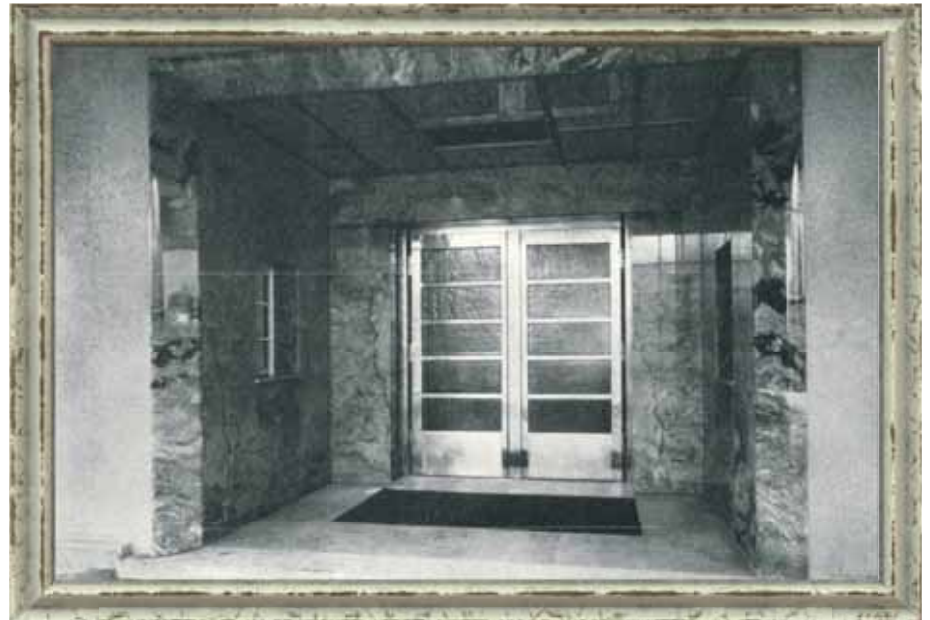
Der ursprüngliche Haupteingang zum Krankenhaus.
