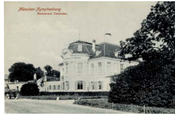
Im Gebäude des ehemaligen Restaurants „Controlor“ (hier eine Postkarte von 1908) nahm das Münchner Krankenhaus seine Arbeit auf; heute befinden sich hier Konferenzräume, der Mitarbeiter-Speise-saal und darüber der Ordenskonvent.
